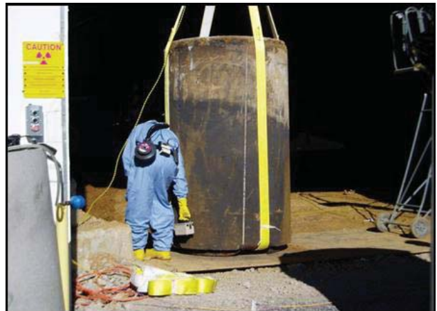
CD-4 TRU Trenches
